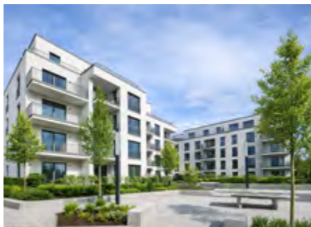
Neubau mit 36 Wohnungen im Quartier „NEUMÜHLE“, Oberursel
